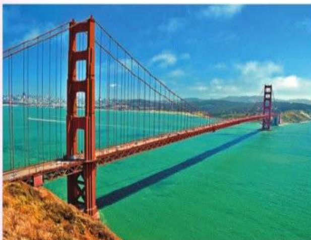
Рис. 148. Мост через пролив Золотые Ворота
